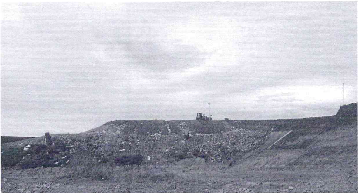
Figura 2-17 – Espalhamento e Compactação dos Resíduos no Aterro Sanitário - UVS Alfenas
